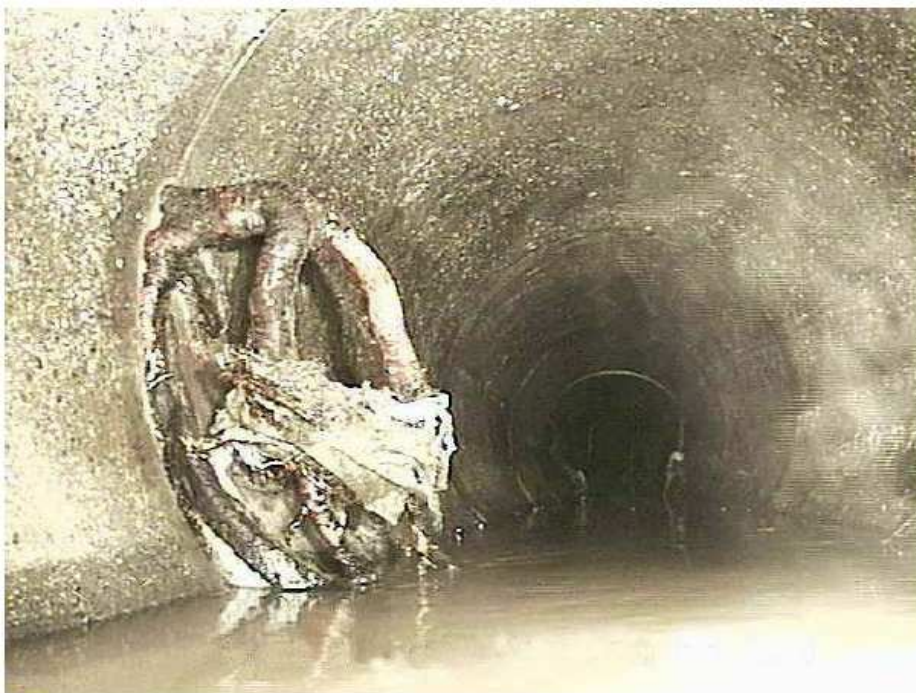
Abbildung 3.9: seitlicher Wurzeleinwuchs
